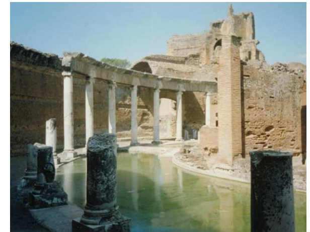
Fig. 17 Tivoli, Villa Adriana, il Teatro Marittimo . Le sconnessioni dell'architrave curvo sono rese evidenti dall'utilizzo di due materiali differenti: un tratto in pietra retto dalla colonna, e un tratto intermedio a forma di cuneo in mattoni.
