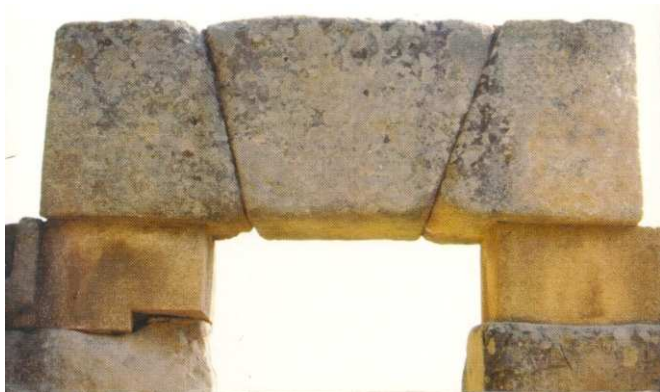
Fig. 15 Tindari, basilica . Architrave prefabbricato.
